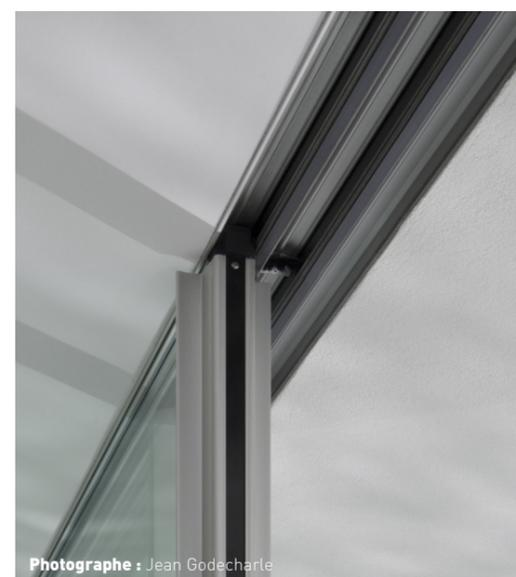
Vue du vantail ouvert, montrant la traverse supérieure encastrée dans le faux plafond.
