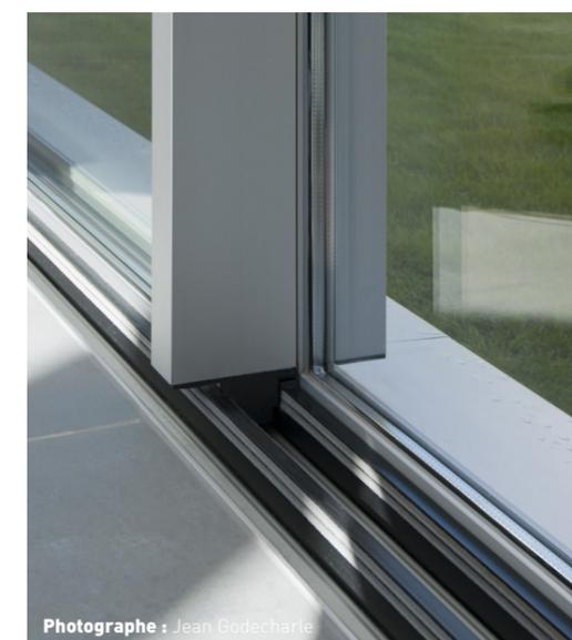
Détail du montant central renforcé dont la dimension dépend de l'inertie nécessaire en fonction du poids du vitrage.
